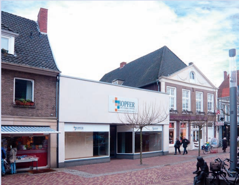
Das Gebäude vor Abriss (oben) und die künftige Fassadenansicht von der Hagenstraße (unten).
