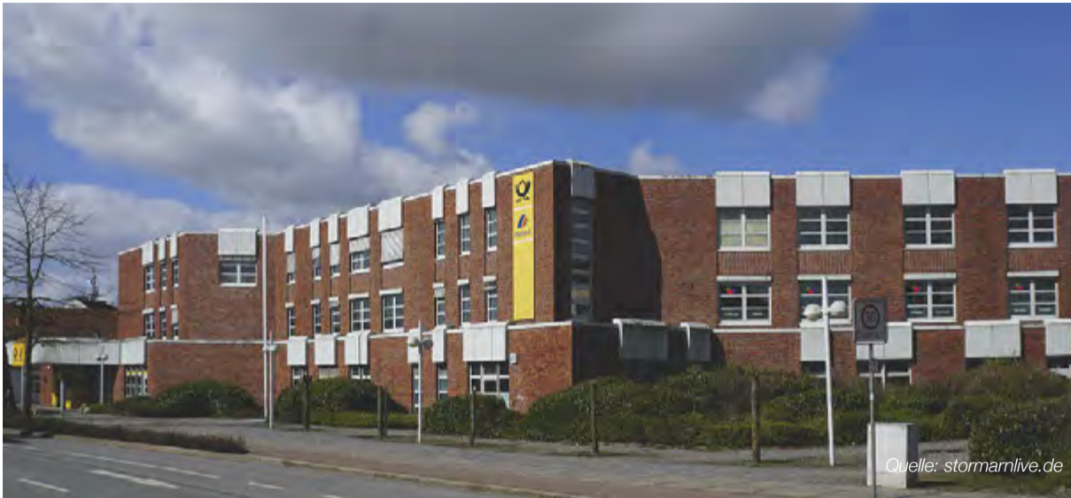
Das ehemalige Postgebäude wurde abgerissen. Nun baut auf dem Gelände LIST BAU Nordhorn ein Nahversorgungszentrum.
