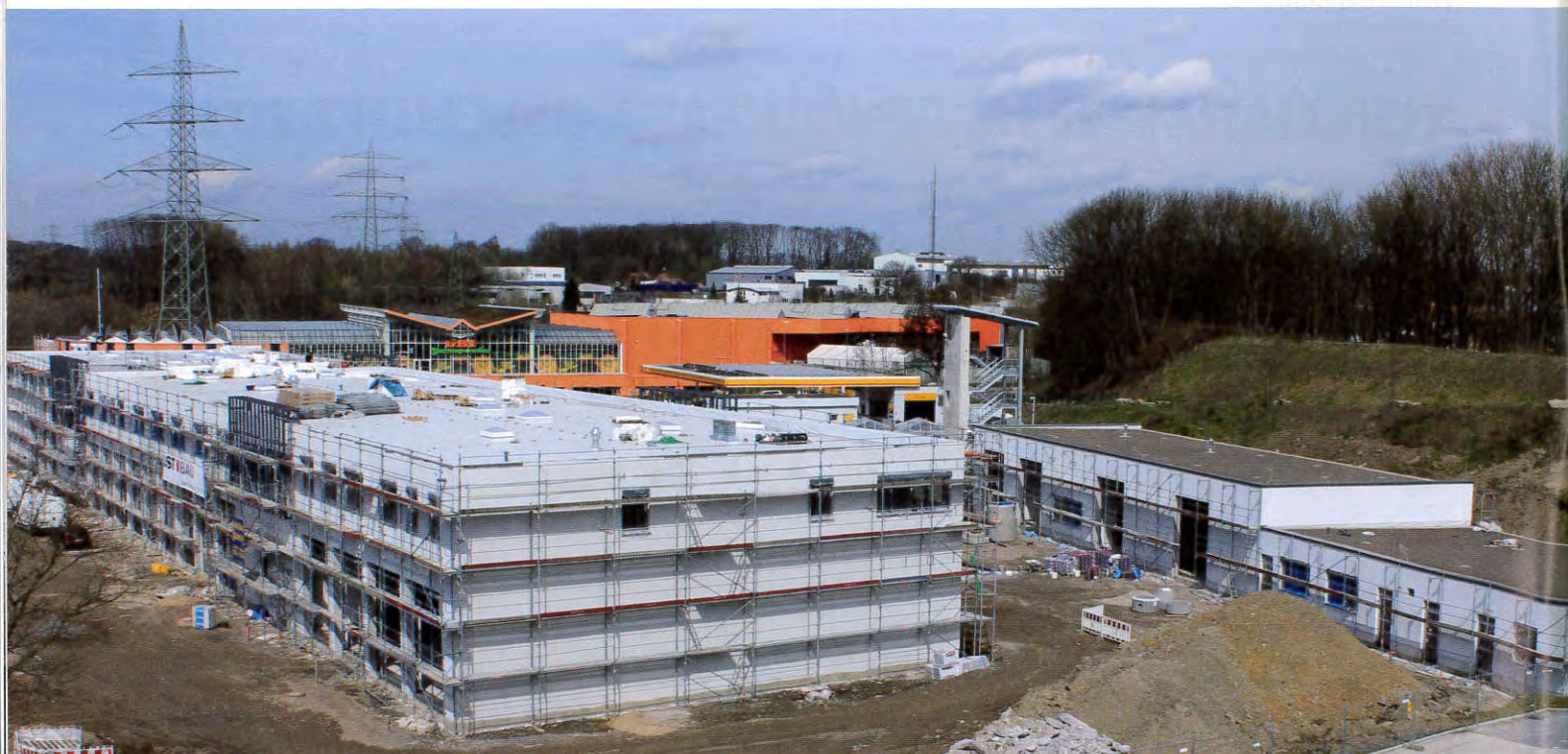
Die neue Feuer- und Rettungswache soll im Oktober 2013 in Betrieb gehen.
