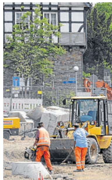
Die Arbeiten an der Umgehungsstraße schreiten voran. FOTO: THEO SCHMETTKAMP
