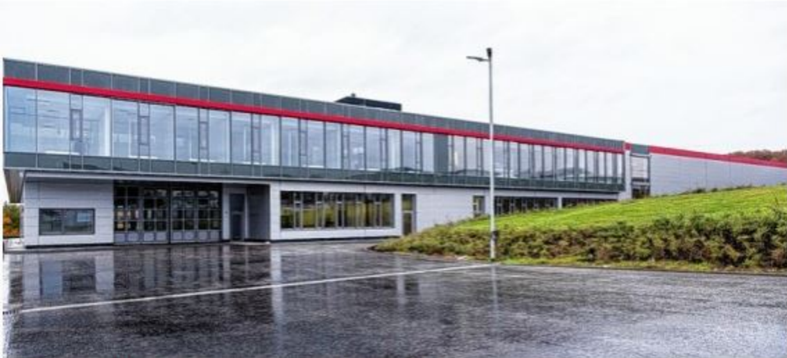
Der Neubau mit seiner Glasfassade. Foto: Maik Molkentin-Grote
