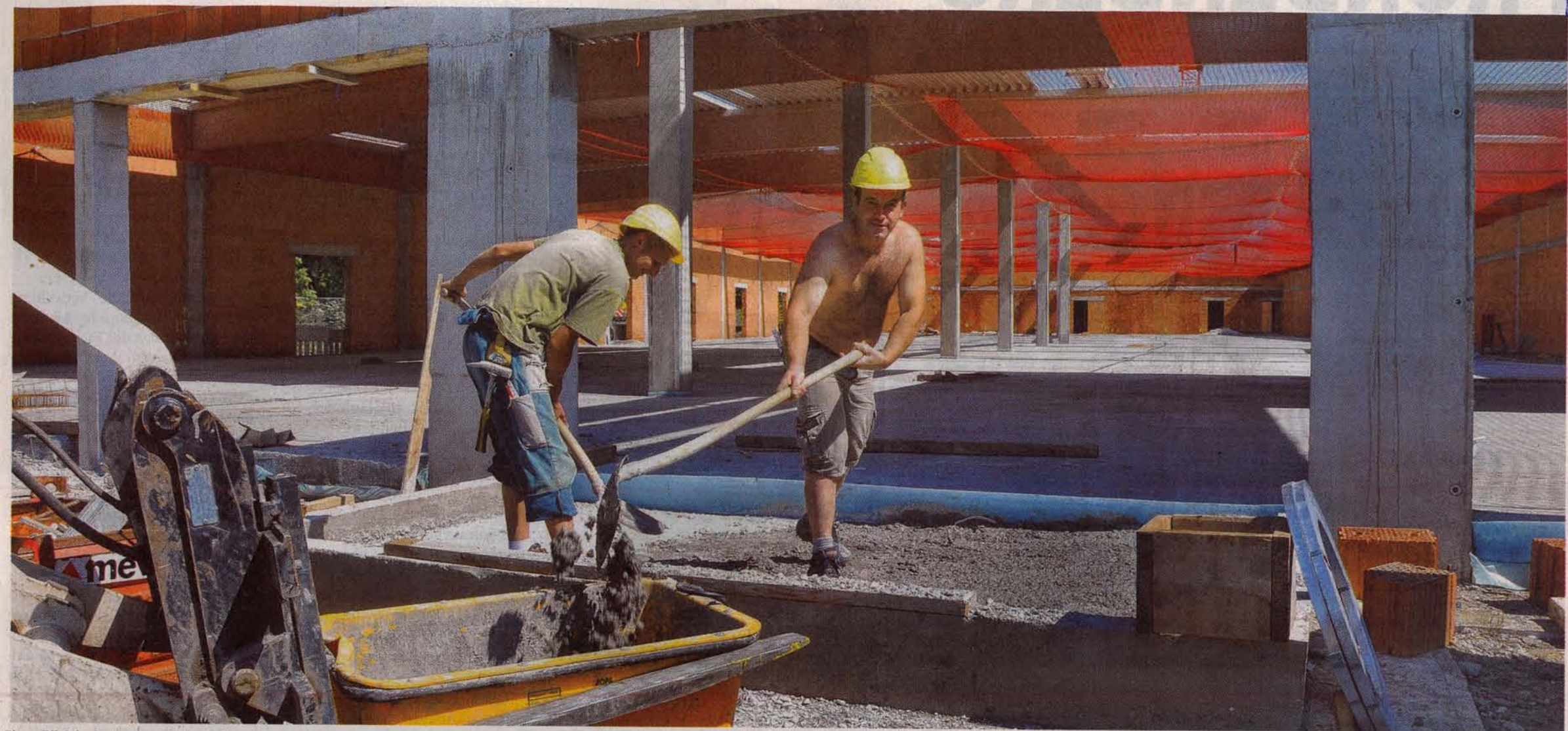
Einen Blick in den neuen Edeka-Markt. Auf dem Foto kann man gut erkennen, welche Ausmaße er annehmen wird. Die Arbeiten sind bereits soweit voran geschritten, dass mit den Dach-Arbeiten begonnen wird.
