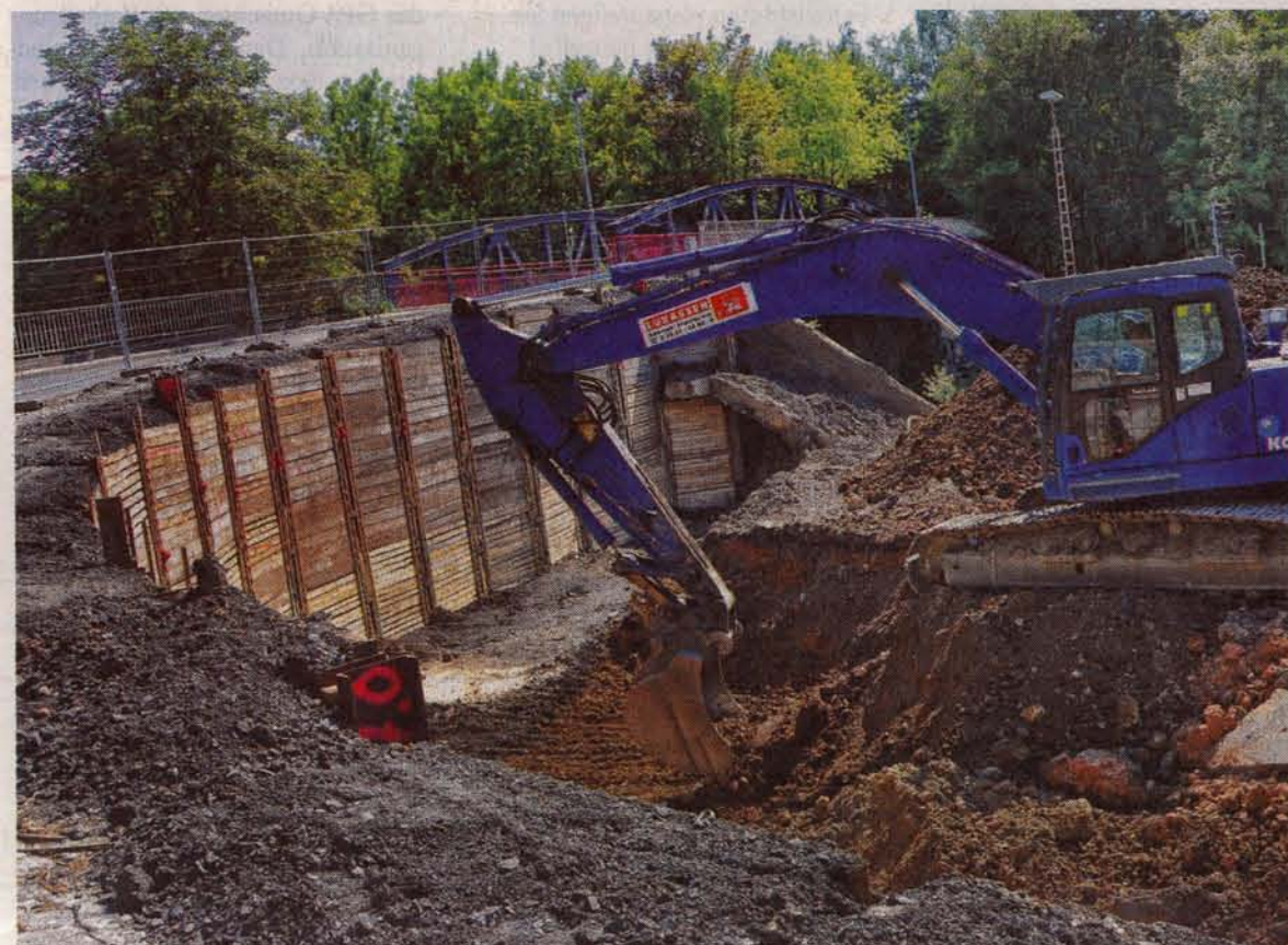
Hier wird die Baugrube für den Siemes-Schuhmarkt ausgehoben. Ein durchaus spektakuläres Bild, sichern doch die hohen Spundwände den Heimkerweg vor der Bahnhofsbrücke ab.
