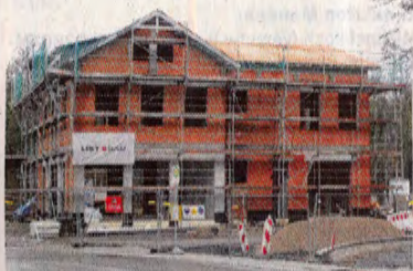
Der Rohbau des neuen Bahnhofsgebäudes.
