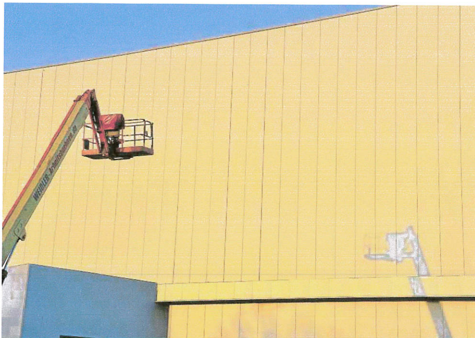
20 Meter hoch ist das neue Hochregallager, das derzeit auf dem Gelände der Firma Heuchemer Verpackung in Miehlen entsteht. Damit stärkt das Unternehmen den Standort. Im Spätsommer sollen beide geplanten Bauabschnitte, Lager und neue Büroräume, fertig sein.
