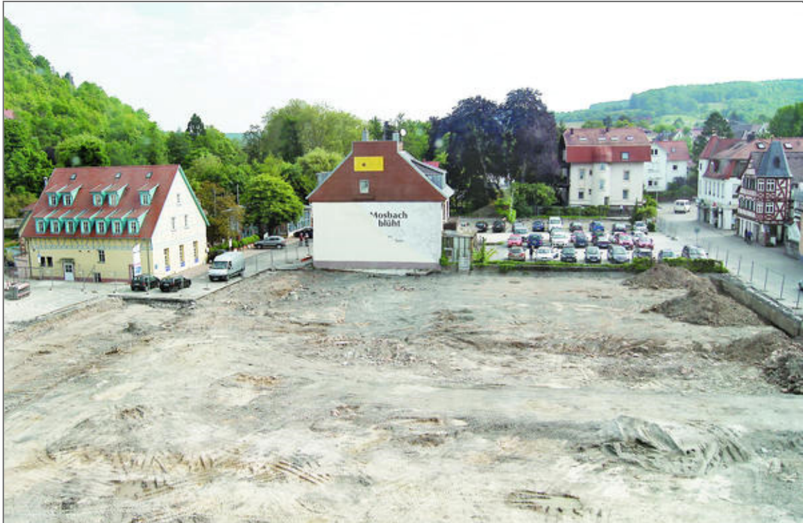
Daumenkino am Gartenweg: Aus der Parkfläche ist über etliche Zwischenschritte inzwischen eine tiefe Baugrube geworden. In Kürze werden für das Quartier an der Bachmühle die Tiefbauarbeiten anlaufen. Fotos: Heiko Schattauer
