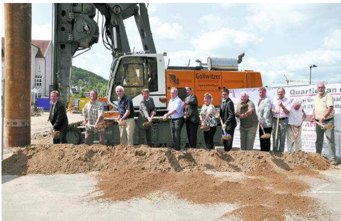
Gemeinsam mit einigen Gästen griff Oberbürgermeister Michael Jann gestern zum Arbeitsgerät für den symbolischen Ersten Spatenstich für das Quartier an der Bachmühle. Bisher wurde dort das Grundstück 'baureif' gemacht. Foto: Stephanie Kern
