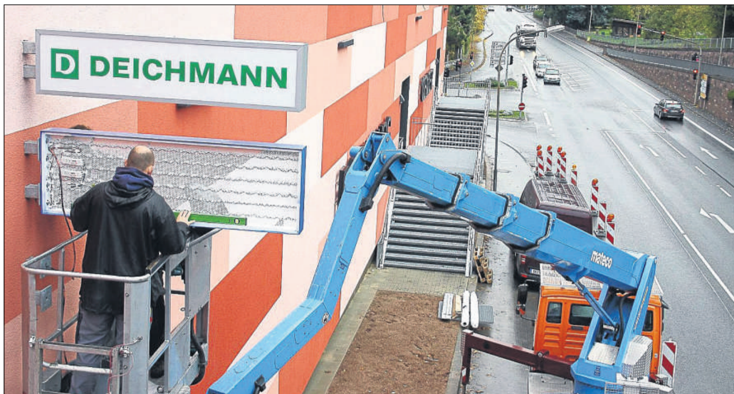
Letzte Handgriffe: Gestern Vormittag befestigten Techniker vom Korb eines Steigers aus noch leuchtende Reklameschilder an der Außenwand des Rotenburg-Centers. Foto: Achim Meyer
